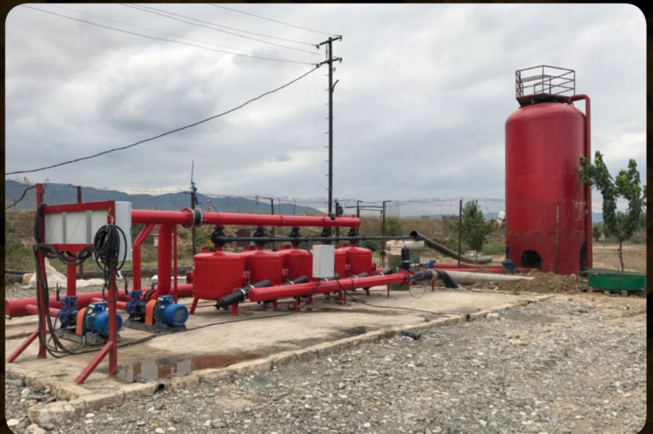
The drip-irrigation system first pumps water from underground. / Կաթիլային ոռոգման համակարգը նախ ջուր կը մղէ գետնին տակէն:
